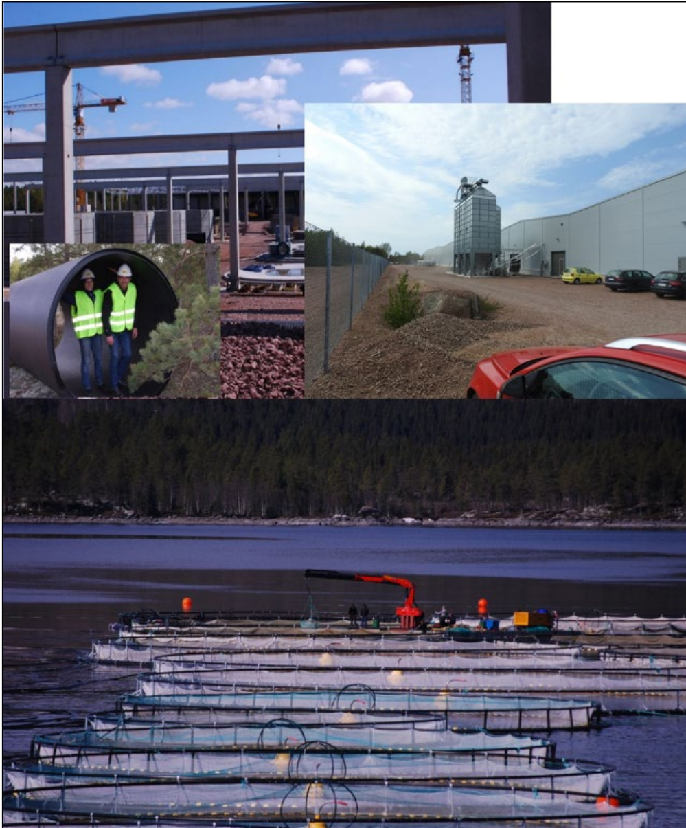
Bild 2. Övre bilden visar byggandet av en så kallad RAS (landbaserad fiskodling) för produktion av 3.000 ton regnbåge per år, belägen på Åland.. Den nedre bilden visar en kassodling dimensionerad för samma produktion, här belägen i en svensk kraftverksdamm i nordvästra Jämtland. Oavsett produktionsform behövs ungefär samma mark/vatten areal Bilder A. Kiessling
